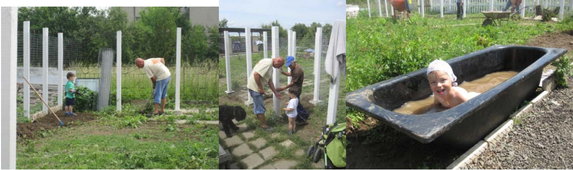
Arbeiten mit Plamen am Außengehege für die Katzen
